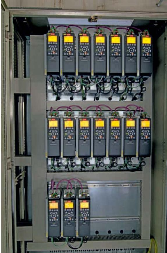
Feldschlösschen setzt auf ein zentrales Anlagenkonzept. Dabei sind alle VLT AutomationDrive FC 300 geschützt in einem Schaltschrank oberhalb der Anlage untergebracht.
