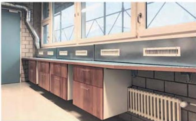
Farbmischraum mit Absaugsystem auf der Arbeitsfläche.
