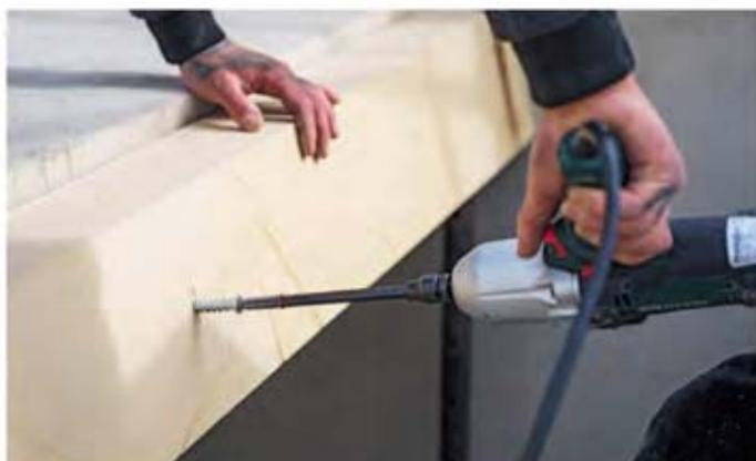
In Dresden werden die Dachstühle des neuen Viertels LYRA-QUARTIER mit HECO-Befestigern erstellt. Die Zimmerei benutzt neben den HECO-CC Vollgewindeschrauben auch MULTI-MONTI TimberConnect Betonschrauben, um das Holz am Massivbau zu befestigen. Mit diesem Produkt hat HECO eine perfekte Kombination aus Schraubanker und Holzschraube entwickelt, die für
